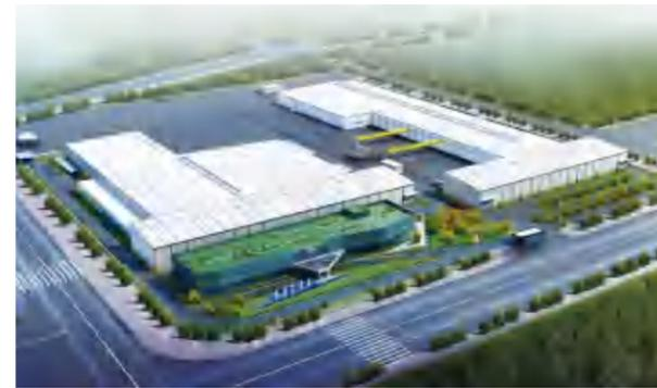
国机集团中机六院设计的博思格建筑系统（西安）有限公司新建工厂工程采用地源热泵、智能照明、精确无功补偿与滤波、空压机余热回收、雨水利用与中水回用等多项绿色技术，可再循环材料使用重量占所有建筑材料总重量的比例达到 12.6%，节能率达到 71.09%。该项目是中国首家通过三星（最高等级）绿色设计标识的工业建筑，获得中国钢结构金奖、全国绿色建筑创新奖二等奖和第三届国际碳金奖。
